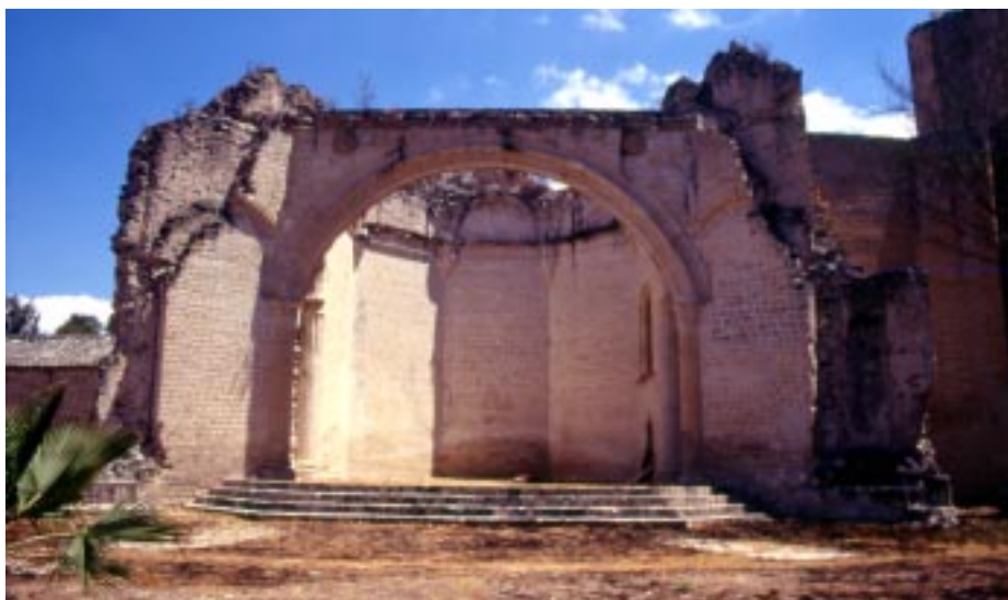
COIXTLAHUACA (MÉXICO). CONVENTO DE SAN JUAN BAUTISTA. CAPILLA ABIERTA.
