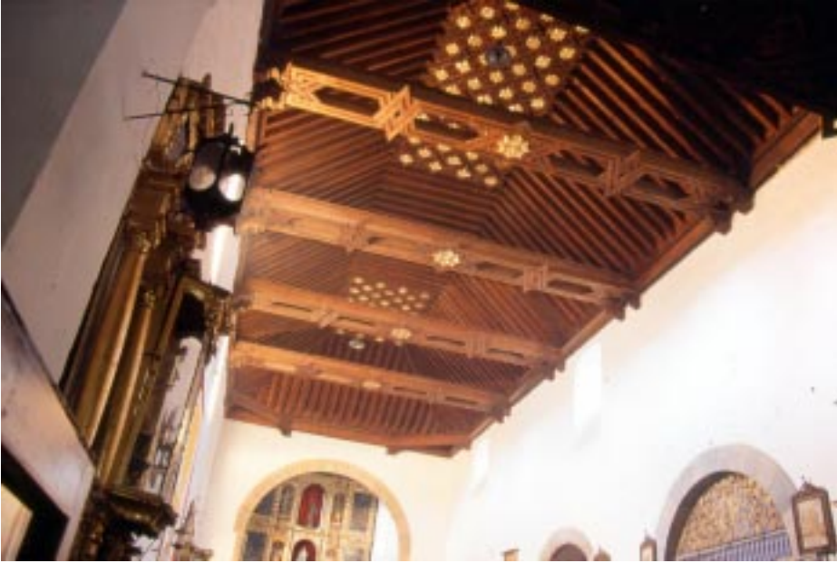
TLAXCALA (MÉXICO). IGLESIA DE SAN FRANCISCO. ARMADURA DE LA NAVE.
