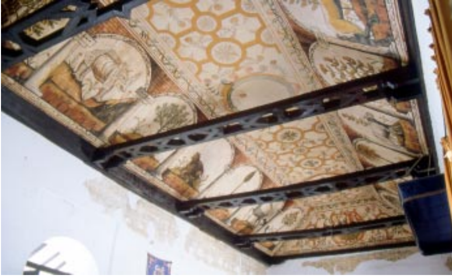
TUNJA (COLOMBIA). CASA DEL FUNDADOR. CUBIERTA DE LA SALA PRINCIPAL.
