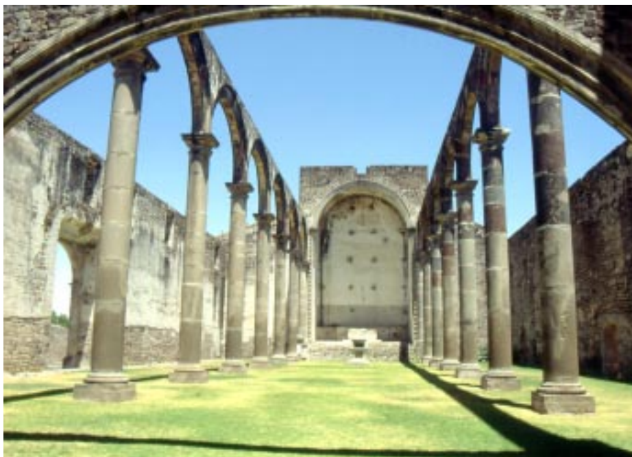
TECALI (MÉXICO). IGLESIA CONVENTUAL. VISTA GENERAL.
