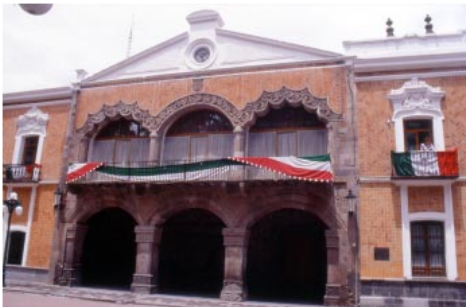
TLAXCALA (MÉXICO). AYUNTAMIENTO. FACHADA.
