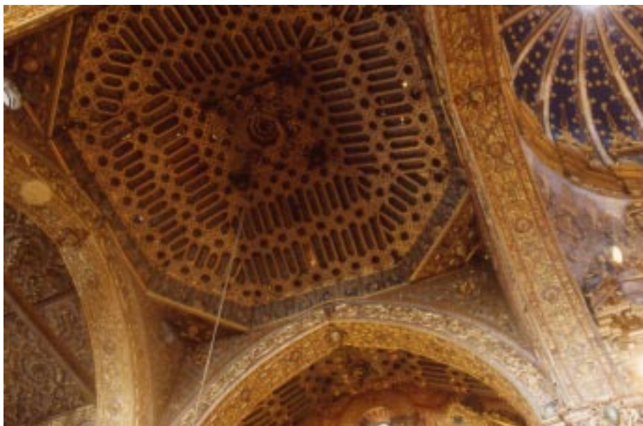
QUITO (ECUADOR). IGLESIA DE SAN FRANCISCO. ARMADURA DEL CRUCERO.
