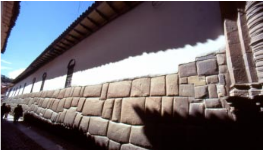
CUZCO (PERÚ). PALACIO ARZOBISPAL. MURO INCAICO.
